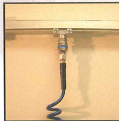
Raccord sur canalisation principale
