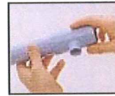
Assemblage avec polymère de soudure
