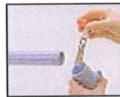
Assemblage avec polymère de soudure
